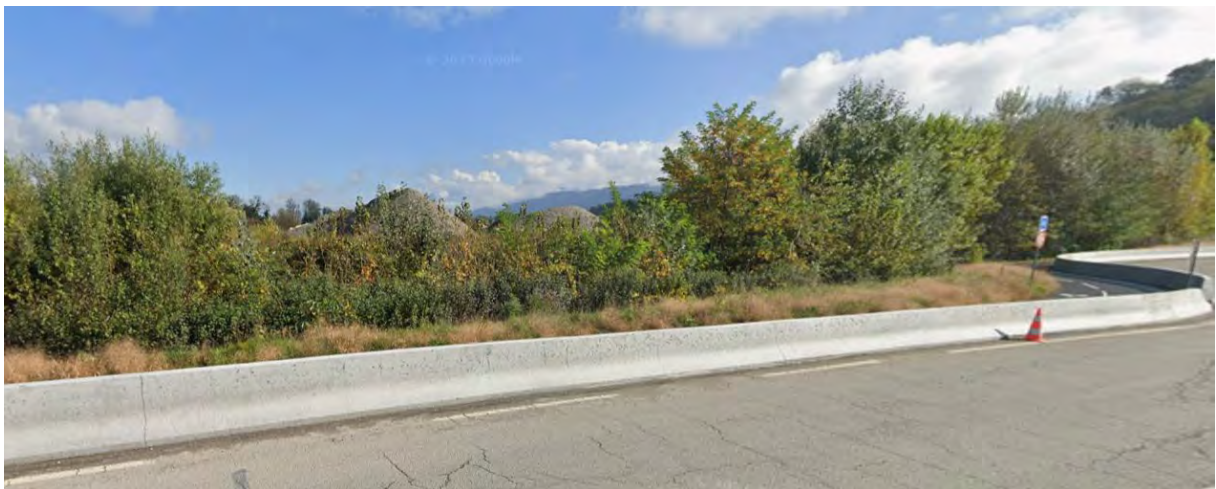
Perception des tas de matériaux en sortie du péage de Montmélian, partiellement dissimulés par un rideau d'arbres – Google Street View, 2024
