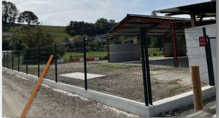
Marais Pose d'une clôture, rénovation de l'évacuation des WC
